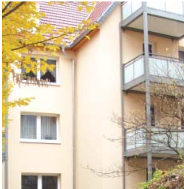
◀◀▶▶ Hofseite am Neumarkt 3 + 4: Ein nagelneues Dach, neue Fenster und ausgewechselte bzw. neue Balkone sind gute Argumente für ein dauerhaftes Mietverhältnis.
