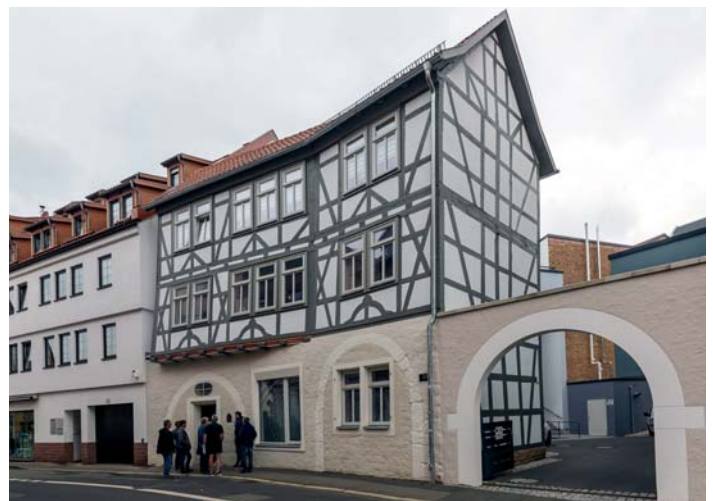
Straßenansicht Hoffnung 38 nach der Sanierung.
