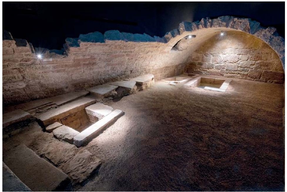
Gesamteindruck MIKWE nach der Restaurierung – mit Präsentation der komplexen Beckenanlage, der Holzrohrleitung und den Resten des später aufgebrachtten Sandsteinbelags.
