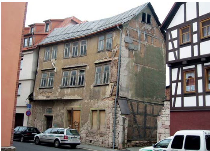
Straßenansicht Hoffnung 38 vor der Sanierung.
